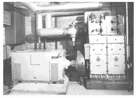
Fig. 23. - La génératrice asynchrone peut aussi être avantageusement utilisée pour des entraînements non hydrauliques. Génératrice asynchrone QO 400 aya 8, forme IM B3 entraînée par une machine à vapeur de la Station d'épuration des eaux (STEP) de Lausanne-Vidy. Caractéristiques:  $U_0 = 380 \text{ V}$ ,  $P_n = 224 \text{ kW}$ ,  $\cos \varphi = 0.81$ ,  $n_n = 760 \text{ min}^{-1}$ . Mise en
