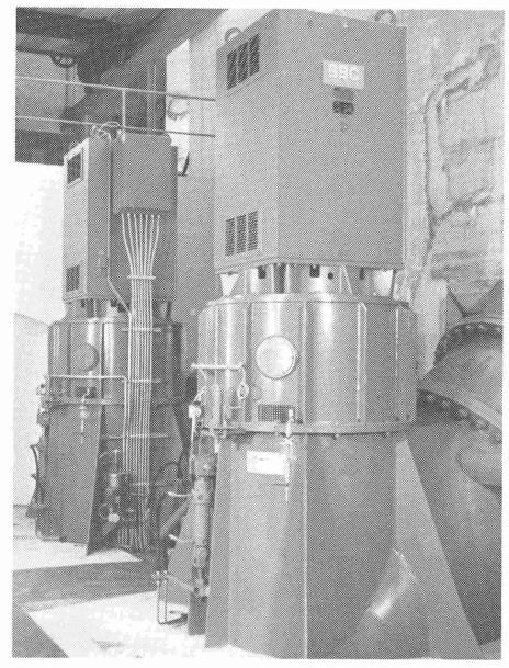
Fig. 12. – Usine hydroélectrique de Manegg de la Fabrique de papier sur la Sihl. Deux génératrices asynchrones type gQOVx 450 bb 10, forme IM V1. Chacune est accouplée à une turbine Kaplan. Caractéristiques (d'une machine):  $U_n = 500 \text{ V}$ ,  $P_n = 315 \text{ kW}$ ,  $\cos \varphi = 0.82$ ,  $n_n = 610 \text{ min}^{-1}$ , vitesse d'emballement = 1310 min $^{-1}$ . Mise en service en 1981, ABB 196 569
