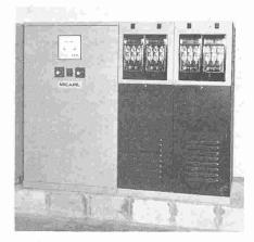
Fig. 11. – Usine hydroélectrique de Moutier. Une des deux armoires avec la commande automatique des batteries de condensateurs de 200 kVAr. Fabrication Micafil, une filiale de ABB. Au total, huit gradins sont disponibles, ce qui exclut une surcompensation à charge réduite. A pleine charge (900 kW), le facteur de puissance passe de 0,85 à 0,98.
