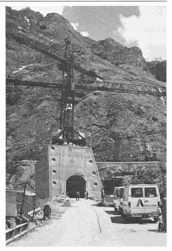
Fig. 3. – Chacune de grues à tour permet de couler 600 m³ de béton par jour.
