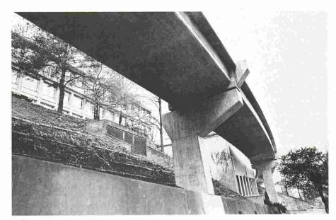
Fig. 8. - Pont de l'EPSIC: pile asymétrique.
