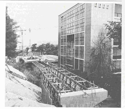
Fig. 3. - Pont de l'EPSIC: échafaudages du tablier.
