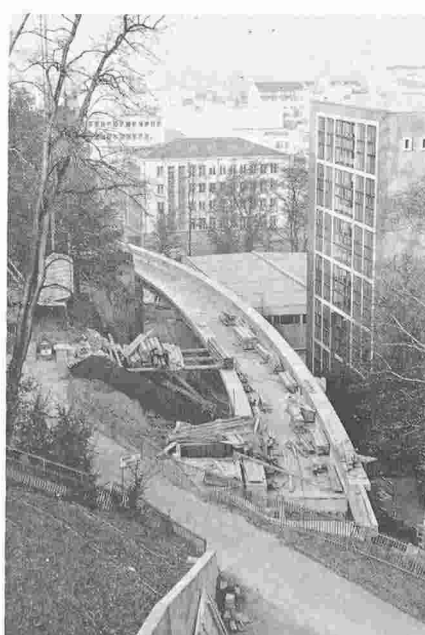
Fig. 5. – Pont de l'EPSIC: tablier terminé.
