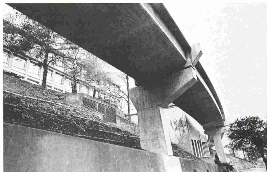
Fig. 8. - Pont de l'EPSIC: pile asymétrique.
