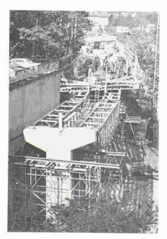
Fig. 4. – Pont de l'EPSIC; échafaudages du tablier.
