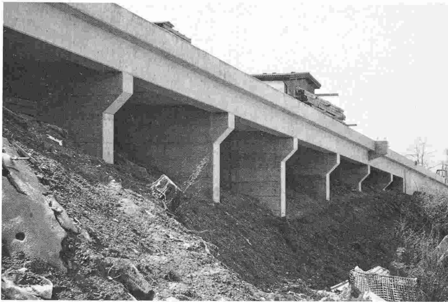
Fig. 10. - Estacade des Côtes-de-Tivoli: vue depuis le bas du talus.
