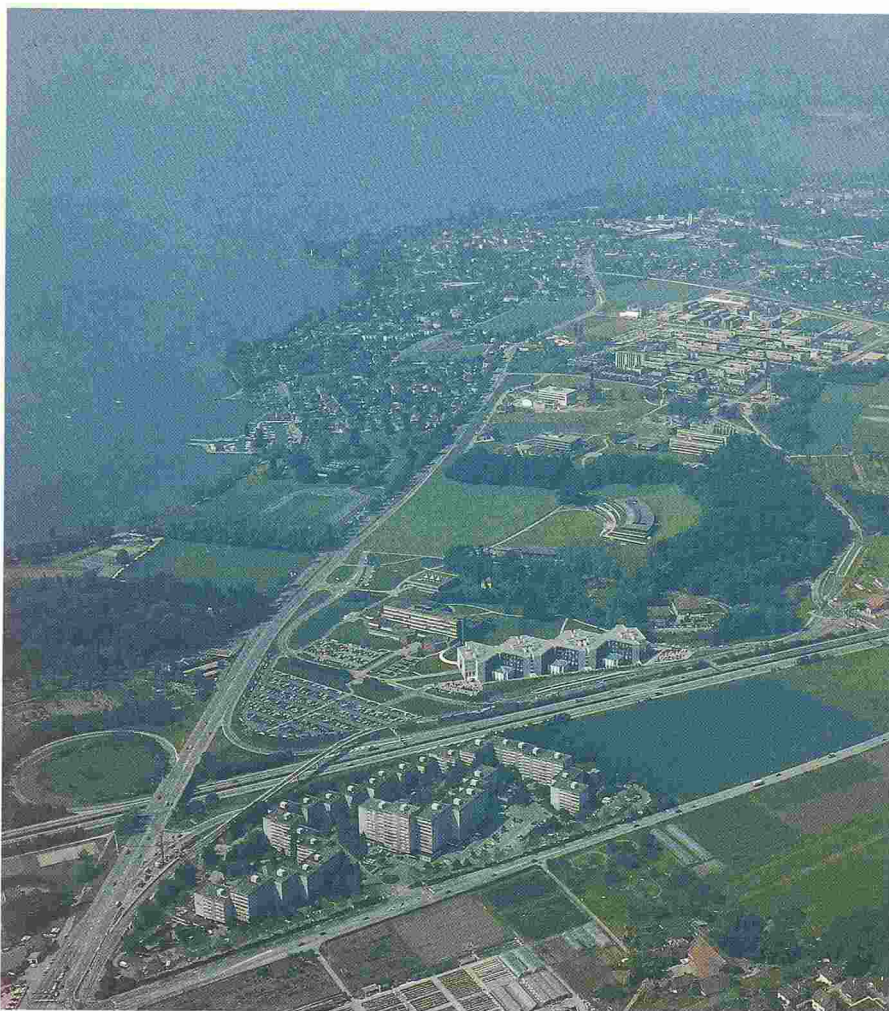
Fig. 8. – Pont de La Bourdonnette : vue aérienne. Le quartier de La Bourdonnette (au premier plan), l'Université de Lausanne (de l'autre côté de l'autoroute) et l'EPFL (au fond). (Photo Germond, Lausanne.)
