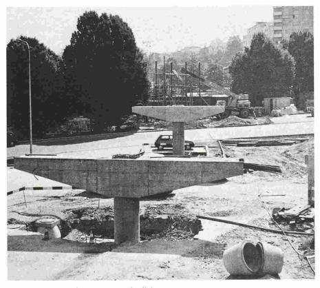
Fig. 3. - Viaduc de Sévelin: piles décoffrées.
