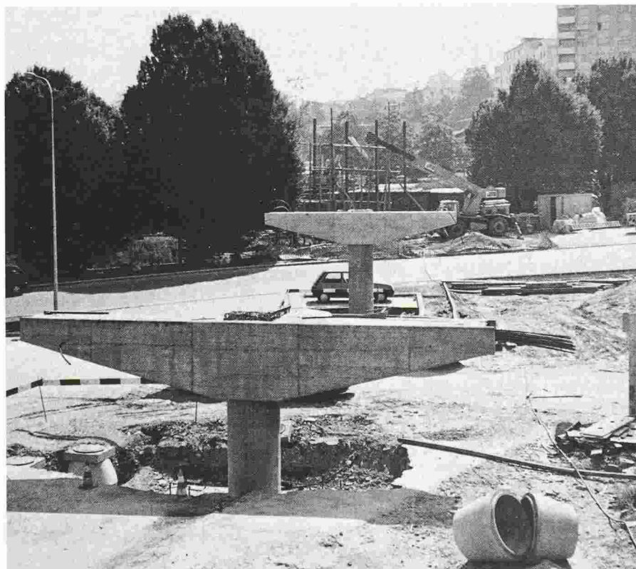
Fig. 3. - Viaduc de Sévelin: piles décoffrées.
