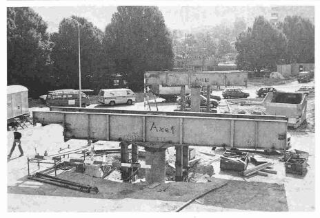
Fig. 2. - Viaduc de Sévelin: coffrages métalliques des piles.
