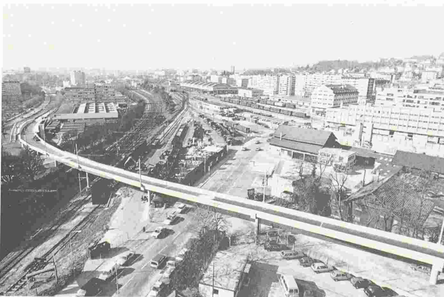
Fig. 1. - Viaduc de Sévelin : vue générale.
