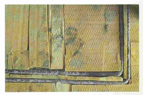
Fig. 3. - Isolation mal posée, ponts phoniques dus aux tuyaux qui coupent l'isolation.
