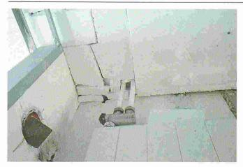
Fig. 4. – Isolation mal posée, les multiples morceaux provoquent des ponts phoniques.
