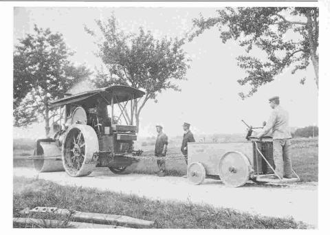
Fig. 7. – Rouleau à vapeur Aveling & Porter en usage sur les routes vaudoises, traînant une piocheuse Zorn (vers 1908).
