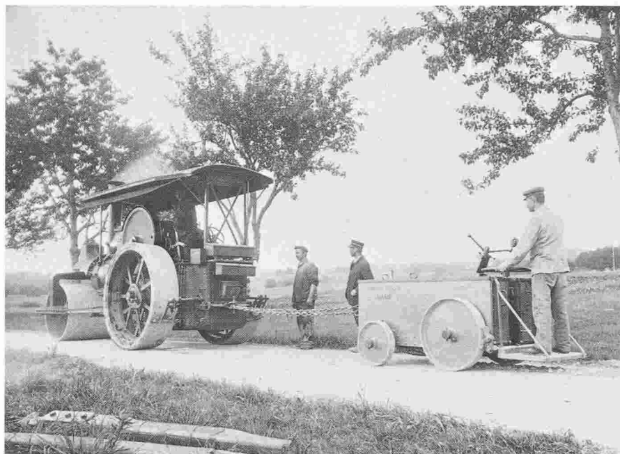
Fig. 7. – Rouleau à vapeur Aveling & Porter en usage sur les routes vaudoises, traînant une piocheuse Zorn (vers 1908).
