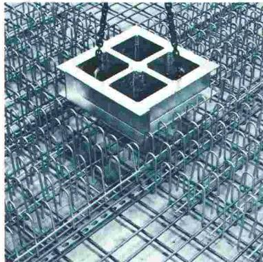
paniers sont montés rapidement, sans travaux de pose compliqués. Il en va de même pour les armatures pour dalles en porte-à-faux Arbo et les appuis Nell d'Aschwanden.
