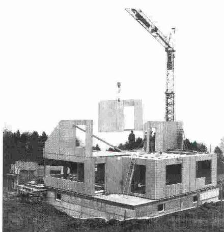
Formés de copeaux de bois résineux liés par des colles sans formaldéhyde, les panneaux HOMOGEN 80 présentent toutes les qualités du bois: capacité portante, résistance aux chocs, stabilité, pouvoir d'isolation, inaltérabilité et facilité de travail. Les éléments de paroi assurent un intérieur sain et permettent une construction rapide parce qu'ils sont livrés prêts au montage. HOMOGEN 80: le progrès dans la technique du bois. Appelez-nous et demandez notre documentation.
