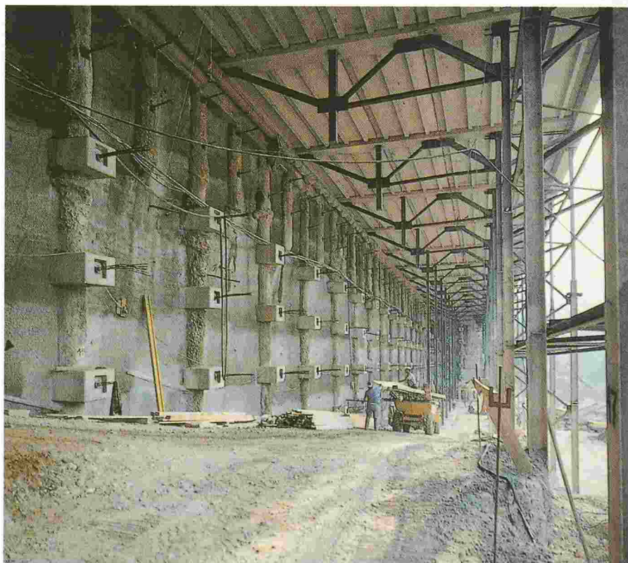
Fig. 5. – Paroi berlinoise et structure provisoire supportant la nouvelle chaussée de la route des Alpes.
