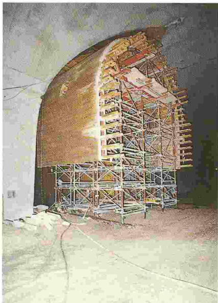
Tunnel est. Coffrage spécial utilisé pour le bétonnage des galeries transversales assurant la liaison entre les deux tubes.
