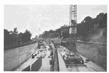
Sur 200 m, l'autoroute accotée à la falaise est bordée d'un long mur ancré profondément dans la roche, et dont l'épaisseur totale atteint par endroits 2 m. La place limitée à cet endroit, l'ampleur de l'ouvrage à réaliser et la densité du trafic qui continue de se dérouler derrière les palissades font de ce chantier un modèle d'efficacité.
