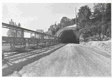
Tunnel est. L'évacuation des déblais depuis le transporteur de l'aléseur jusqu'à l'extérieur du tunnel se fait par un transporteur unique à bande courbe d'environ 2500 m.
