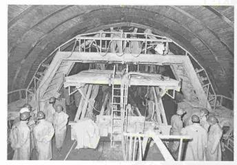
Tunnel est. Plate-forme de travail du traîneau de service. Des visiteurs visiblement très intéressés par les travaux d'avancement : les membres SIA du Groupe spécialisé pour les travaux souterrains, lors de leur assemblée du 19 septembre 1985.
