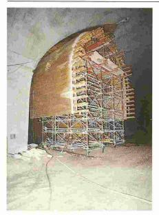
Tunnel est. Coffrage spécial utilisé pour le bétonnage des galeries transversales assurant la liaison entre les deux tubes.
