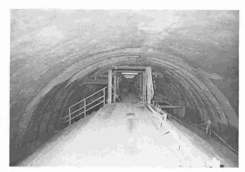
Tunnel est. Immédiatement derrière l'aléseur Ø 11,0 m, on consolide si nécessaire le tunnel à l'aide de boulons d'ancrage, de béton projeté, voire par la pose de cintres, de sorte que les autres opérations se déroulent sous une voûte déjà stabilisée.
