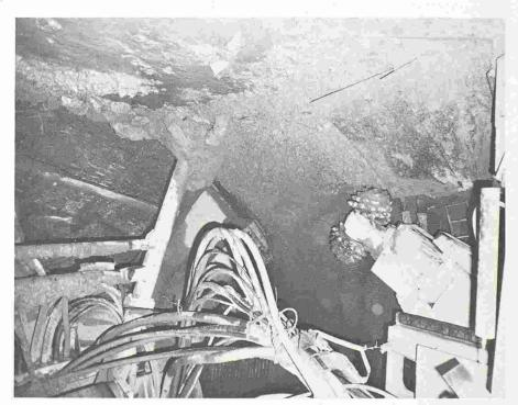
Tunnel est. Un des équipements pour passer de l'excavation de profil circulaire, obtenu par le tunnelier, au profil en fer à cheval a été réalisé par le montage de deux têtes haveuses montées directement de chaque côté sur la partie inférieure du traîneau de service. Caractéristiques de ces deux foreuses ponctuelles:
