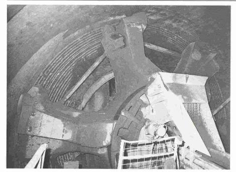
Tunnel est. Vue partielle de la tête rotative d'alésage de Ø 11,0 m du deuxième tunnelier en plein travail (tube nord, 19 septembre 1985).
