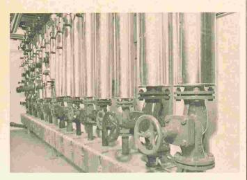
Collecteurs de chauffage Strawanorm. - Installation isolée.
