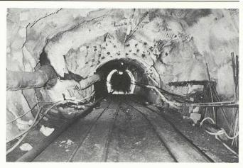
Ilanz II, galerie en charge Panix-Ruschein, lot A. A cet endroit également il a fallu retirer le tunnelier après 1765 m de forage mécanique. On en a profité pour créer un croisement pour les trains de galerie avant de poursuivre l'avancement à l'explosif en direction de Ruschein.
