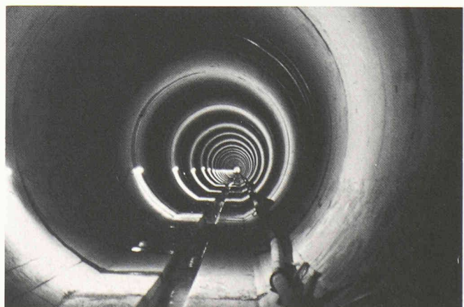
Lot 2. Galerie terminée, munie de son revêtement définitif. Ce lot, long de 4,4 km, a été entièrement excavé au tunnelier (Wirth, type TBS III 520 E, \phi de forage 5,20 m).
