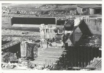
Ouvrage de prise sur le Rhin à Tavanasa, constitué d'un barrage mobile à deux pertuis, d'une prise d'eau latérale avec grille et d'un bâtiment de service de commande.
