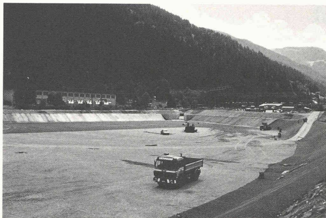
Ilanz I. Bassin de compensation de Tavanasa – 150 000 m 3 , cote de retenue 793 m – en cours de revêtement bitumineux. Au milieu, à gauche, on reconnaît l'usine des Forces motrices du Rhin antérieur SA, dont l'eau motrice est reprise par Ilanz I.
