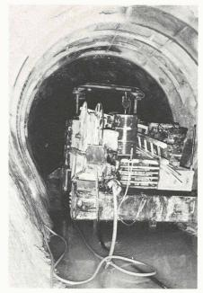
La galerie en charge Tavanasa-llanz est subdivisée en trois lots. Si les lots 2 et 3 ont pu être excavés entièrement au tunnelier pleine section, pour le lot 1, en revanche, on a dû abandonner le forage mécanique et même procéder à une contre-attaque à partir de Tavanasa. Notre photo: Jumbo à deux bras, sur pneus, à environ 550 m de la prise d'eau de Tavanasa.
