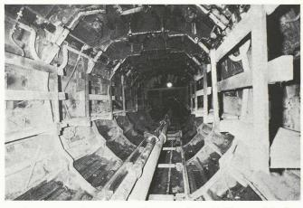
Lot 3 de la galerie en charge Tavanasa-llanz. Entièrement foré au tunnelier, ce tronçon est actuellement en cours de bétonnage. Le coffrage télescopique mis en place permet des étapes de 20 à 25 m par jour. La longueur totale de ce lot, qui comprend également la cheminée d'équilibre d'llanz I, est de 4000 m.
