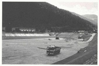
llanz I. Bassin de compensation de Tavanasa – 150 000 m³, cote de retenue 793 m – en cours de revêtement bitumineux. Au milieu, à gauche, on reconnaît l'usine des Forces motrices du Rhin antérieur SA, dont l'eau motrice est reprise par llanz I.
