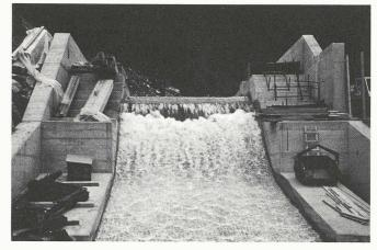
llanz II, prise d'eau du Val Siat. Dimensionnée pour capter au maximum 5 m³/s, l'eau, après avoir passé par le dessableur, rejoint directement la galerie en charge du barrage de Panix-Ruschein à l'aide d'un puits incliné.
