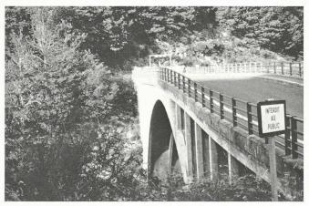
Fig. 4. – Photographie prise en 1980, ailleurs dans le Massif central (pont d'Arpiat): arc en béton construit en 1957, encastré entre deux collines dont l'une glisse vers l'autre. Comparer le profil en long du tablier à celui de la figure 2. Lorsque cette photo a été prise, deux rotules s'étaient déjà créées.
