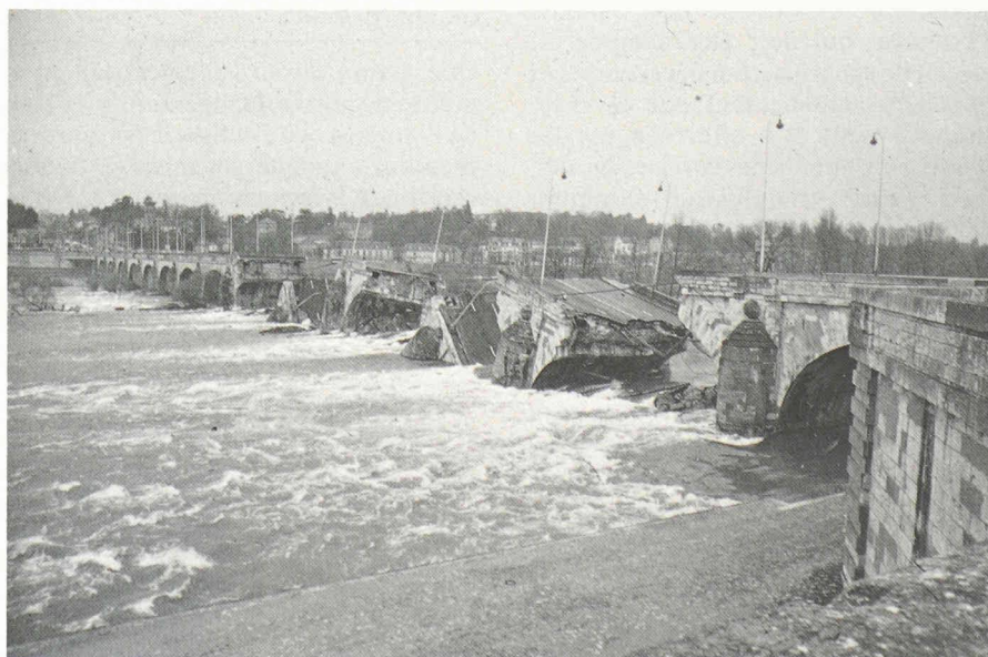
Fig. 17. – Effondrement du pont Wilson, sur la Loire, à Tours, le 9 avril 1978 : le niveau du fond du lit du fleuve s'est progressivement abaissé, notamment à la suite des extractions de sable effectuées en aval (même très loin).
