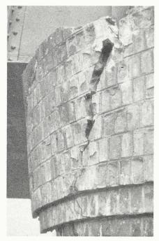
Fig. 11. – Blocage d'appareils d'appui métalliques : une fois ces appareils grippés, faute d'entretien, le raccourcissement thermique du tablier entraîne un morceau de la culée.
