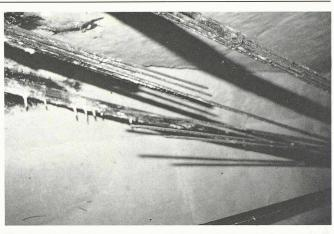
Fig. 8. – Le résultat un quart de siècle plus tard : outre la rupture de certains fils et la corrosion des autres, noter la présence de stalactites : l'eau qui a cheminé le long des armatures de précontrainte a d'abord percolé à travers la masse de béton.
