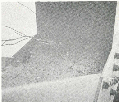
Fig. 12. – Ne pas confondre une poutre métallique et un jardin d'agrément ! Il est impardonnable de laisser ainsi la terre s'accumuler dans une ossature métallique, au point que la végétation a fini par s'installer.
