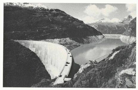
Dans la partie supérieure de la vallée de Vals, au pied de la masse escarpée du Zervreilahorn — dont un géologue a dit qu'il était la plus étrange figure de nos Alpes —, un lac artificiel d'une capacité de 100 millions de mètres cubes, à la fois sauvage et charmant, a été créé. Derrière un barrage-voûte de 151 m de haut et d'un volume de 650000 m³ de béton, il accumule les eaux du Rhin de Vals et de ses affluents supérieurs.
