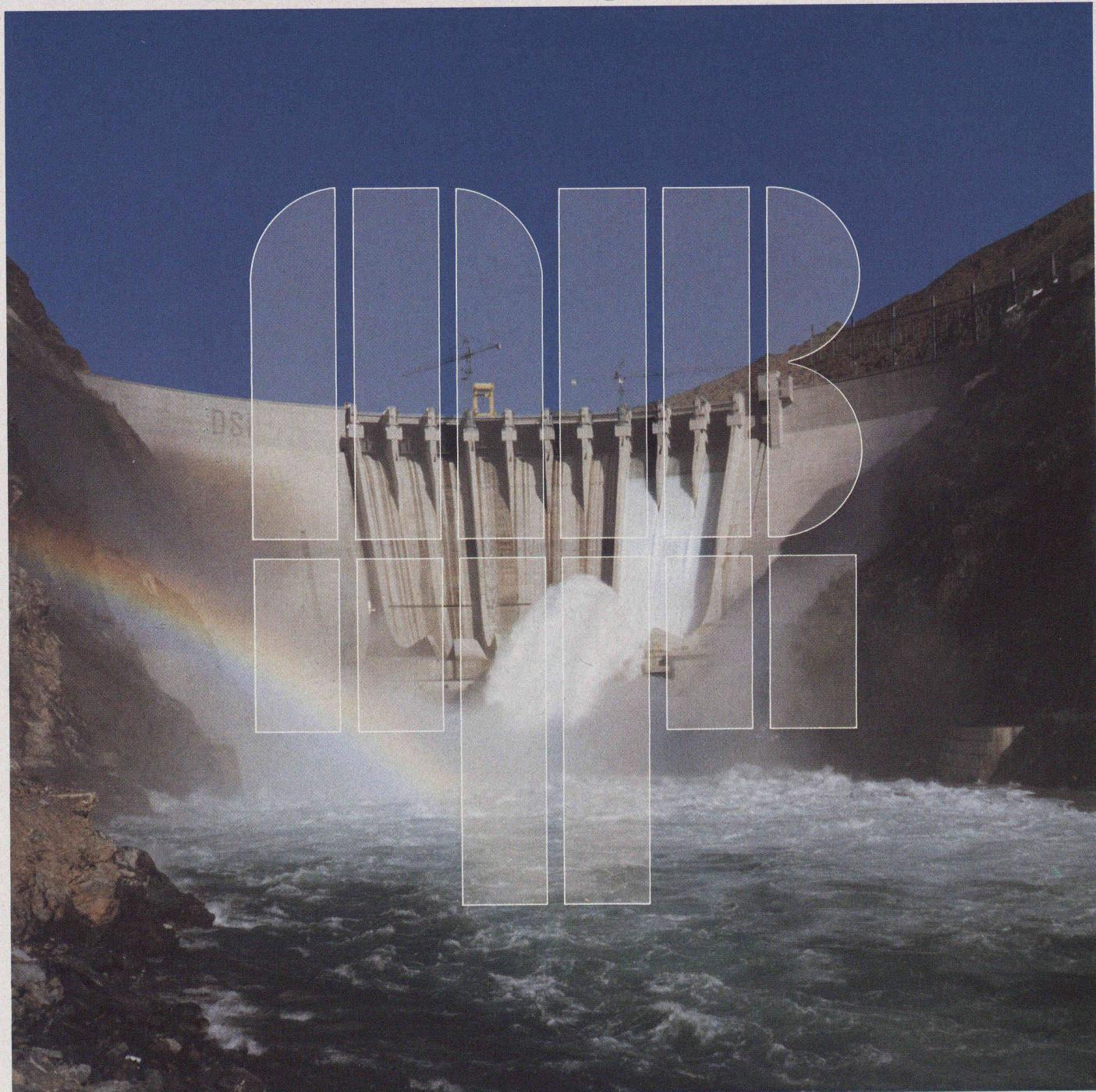
Barrage de Karakaya en Turquie: 630000 m<sup>3</sup> de béton au superfluidifiant Rheobuild.
