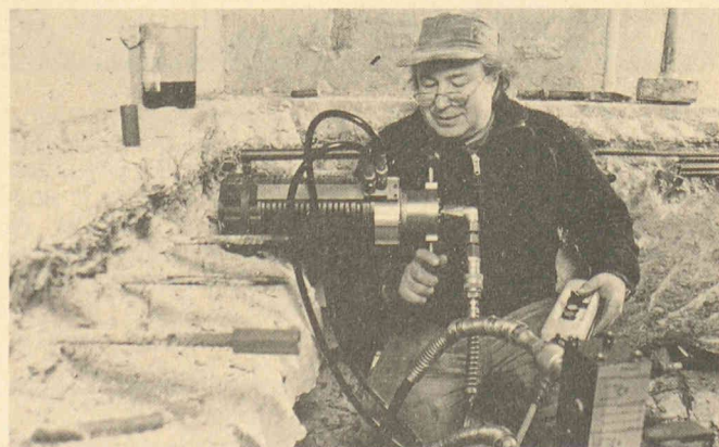
RER Zurich: filetage Swif conique, pressé avec l'appareil MINI.
