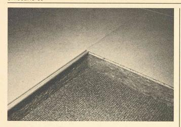
Le système d'isolation Gantner-natura est destiné avant tout aux combles non chauffés dont le plancher doit être praticable. Les éléments sont ajustés sans nivellement, sans collage ni perçage et ils forment un sol parfaitement plan, égalisant les petites irrégularités du sol et pouvant supporter des charges jusqu'à 2140 kg/m². Selon la nature du sol, un pare-vapeur peut être nécessaire.
