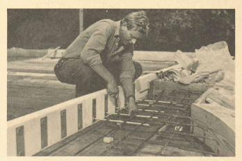
Insertion après coup des barres de raccordement d'armatures à travers l'Iso-Elément Lenton.
