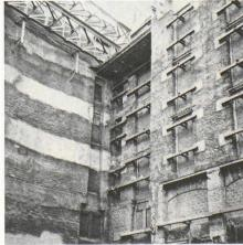
Vue sous le même angle, pile et face... Le maintien artificiel de la façade (immeuble Camoletti, rue de la Corraterie).
