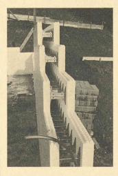
Le système de construction isolant Argisol repose sur des éléments de coffrage en polystyrène expansé. La résistance mécanique élevée de ces éléments permet de les remplir de béton par hauteur d'étage et de rationaliser ainsi considérablement les travaux de construction.
