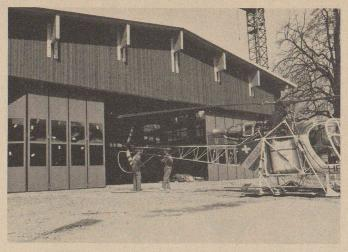
Porte coulissante et pliable à 20 panneaux pour le hangar d'un Super Puma. Devant le hangar: un Lama.
