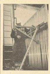
Ces derniers, de type composite (en général bois et métal), sont lourds, doivent être mis en œuvre par des moyens de levage et de manutention onéreux, nécessitent une main-d'œuvre hautement qualifiée et n'ont qu'une durée de vie limitée. Les coffrages Salas, tout en offrant les caractéristiques techniques désirées (modules d'élasticité et d'inertie, résistance, etc.), sont de 2 à 6 fois
