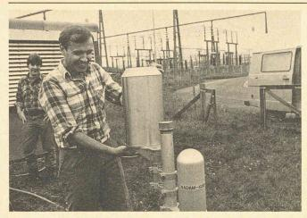
Installation du pluviomètre (à gauche) près de la sonde de mesure de la radioactivité NADAM à la centrale nucléaire de Beznau. (Photo: Centrale nucléaire de Beznau.)
