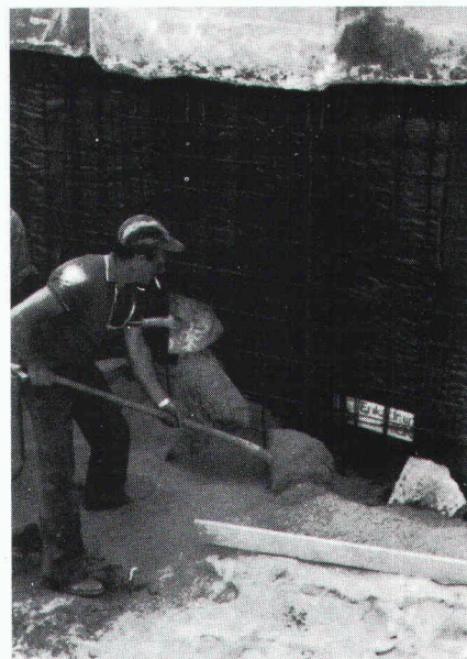
Reprise en sous-œuvre avec la natte Enkadrain CK déjà posée en guise de coffrage.
