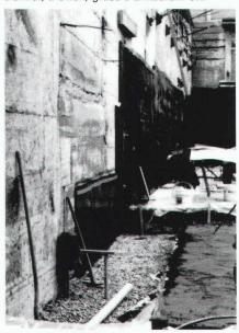
drainage et de filtration Enkadrain, utilisée partout où il s'agit, pour des raisons techniques ou économiques, de bétonner directement sur le terrain (roche, moraine), sans perte de place. Enkadrain CK est composé d'une masse filtrante à structure tri-
