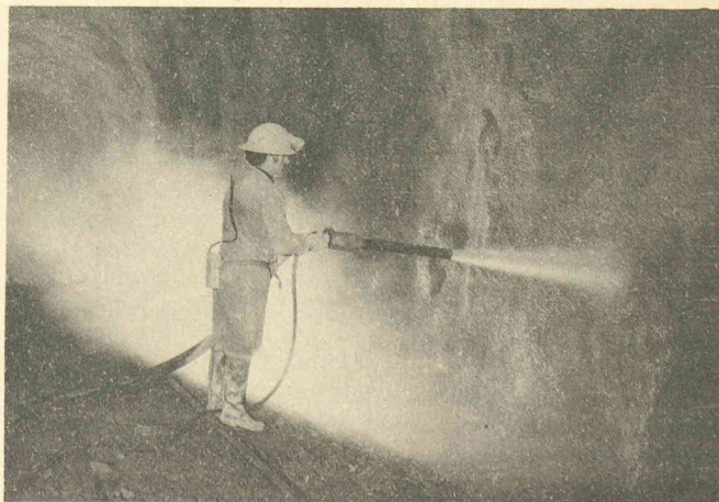
Application de béton projeté dans un tunnel.
