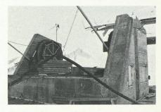
Fig. 2. – Le massif d'ancrage des câbles porteurs du téléphérique avant sa couverture.
