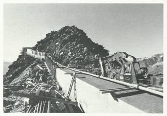
Fig. 4. – La galerie de communication entre le bâtiment principal et la partie ouest en cours de bétonnage (état au 23.10.1985).
