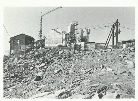
Fig. 1. – Vue générale du chantier ; de g. à d. : station du téléphérique, au premier plan le téléphérique de service avec son pylône d'arrivée, au milieu s'élève le bâtiment principal. L'engin de levage ainsi que la tour à béton ont été acheminés en pièces détachées au moyen du téléphérique de service.
