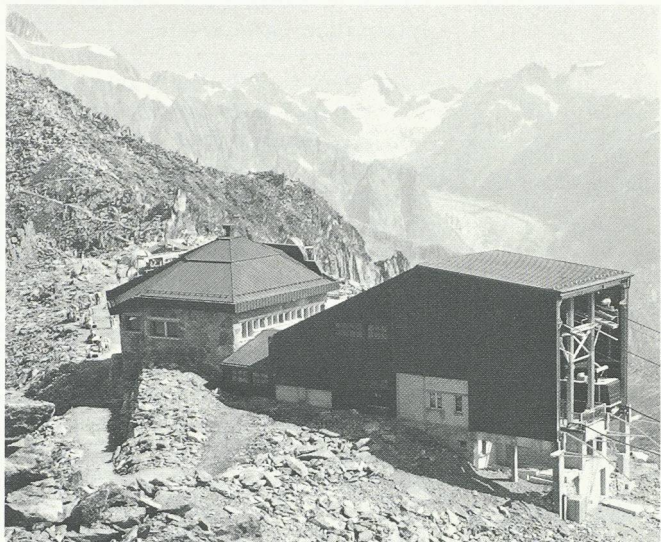
Fig. 8. – Le même bâtiment principal avec la station supérieure du téléphérique qui lui est dorénavant liée. Vue depuis le Fiescherhorli (état au 10.8.1988).
