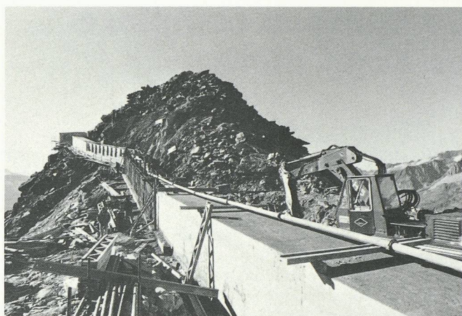
Fig. 4. - La galerie de communication entre le bâtiment principal et la partie ouest en cours de bétonnage (état au 23.10.1985).
