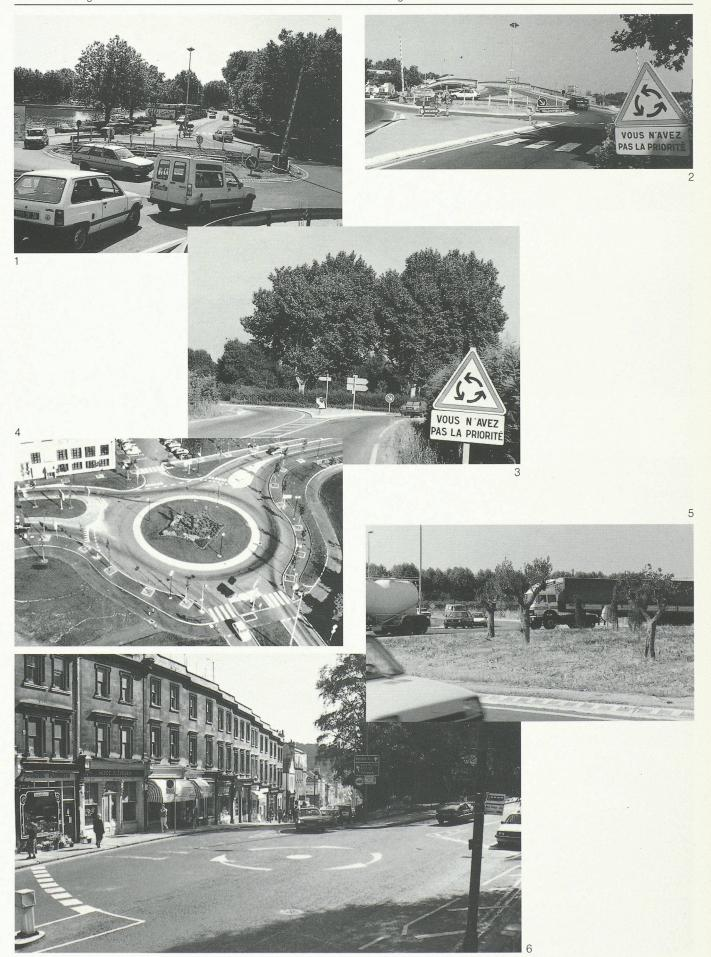
Fig. 6. – Les giratoires en kaléidoscope : giratoire franchi diamétralement par une ligne ferroviaire secondaire (1—2), giratoire récent inscrit autour d'un massif d'arbres vénérables (3), giratoire avec pistes cyclables latérales (4), oliveraie maintenue dans l'anneau d'un giratoire (5), le giratoire ponctuel – sans obstacle central (6).
