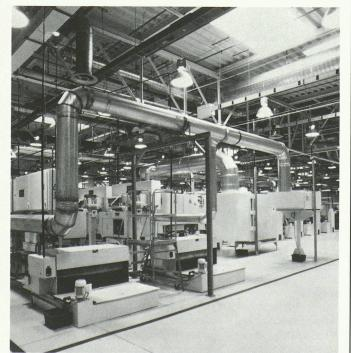
Halle de production avec introduction d'air neuf par des gaines au plafond, comportant des diffuseurs à pulsion giratoire; l'air extrait est évacué par des gaines séparées. (Photo Sulzer.)
