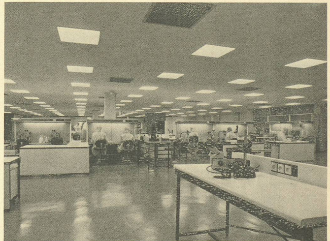
Local de production avec soufflage d'air par le plafond. L'air extrait est évacué par les gaines montées sur les parois arrière des salles. (Photo Sulzer.)
