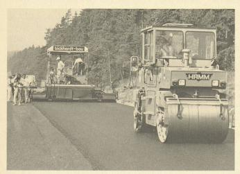
Application du mélange d'asphalte sur le tronçon d'essai de l'autoroute A5. (Photo: Degussa AG.)
