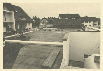
Le toit plat du Centre communal de Nürensdorf (ZH) en cours d'exécution: surface partielle étanchée avec le Sarnafil sur la barrière de vapeur collée en plein et déjà séparée par secteurs (arrière-plan); surface préparée avec des joints de séparation, qui sera séchée après les chutes de pluie (premier plan).
