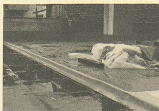
Le joint de séparation avec le Sarnafil jaune, compatible avec le bitume, protège efficacement la surface partielle terminée de l'eau se trouvant sur la barrière de vapeur.
