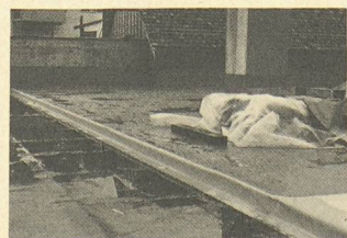
Le joint de séparation avec le Sarnafil jaune, compatible avec le bitume, protège efficacement la surface partielle terminée de l'eau se trouvant sur la barrière de vapeur.
