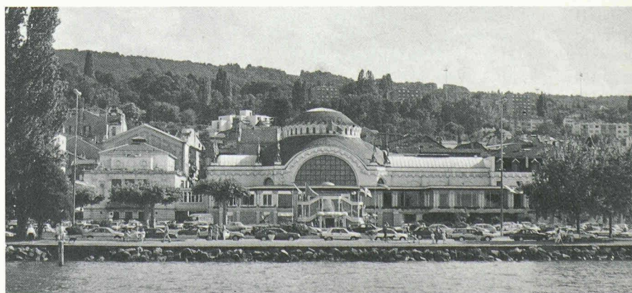
Evian, le casino. A droite, la salle des fêtes et les salons de jeux (architecte A. Hébrard, 1912). A gauche, relié par une passerelle, le théâtre (Jules Clerc, architecte, 1883).
