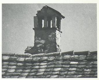
Fig. 2. – Dégâts à la cheminée, dus à la condensation des gaz de fumée
