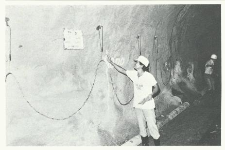
Fig. 3. - Petite sismique: géophones accrochés au parement.
