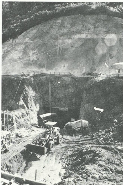
Fig. 6. - Site de Tanggari: entrée de la galerie d'amenée d'eau.
