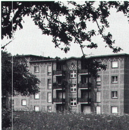
Cité résidentielle « Binzhof » de l'entreprise Sulzer, Oberwinterthur
