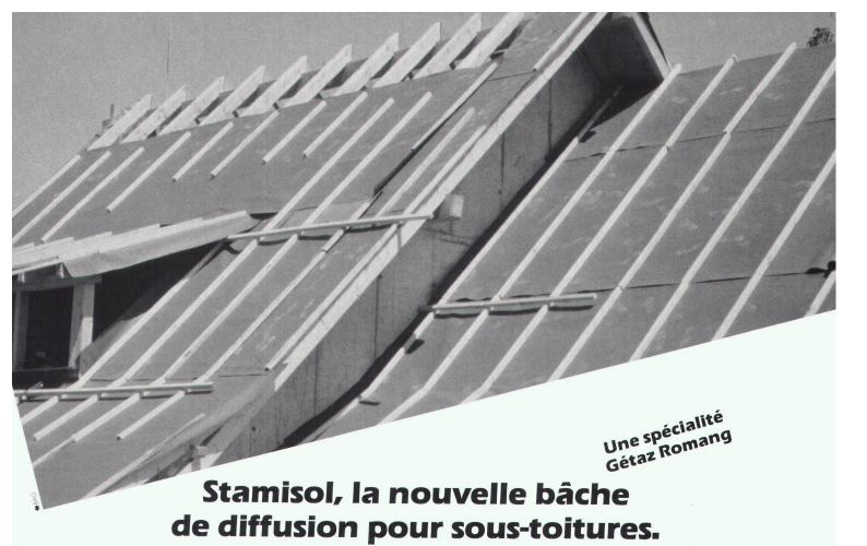
Stamisol est une bâche de diffusion idéale pour la protection des éléments de construction et des combles sous-jacents, grandes ou
