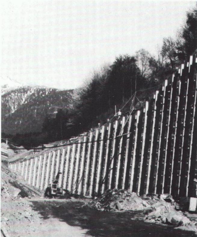
Murs de soutènement dans la partie du tunnel de Gstipf (215 m) réalisée à ciel ouvert.
