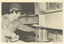
Fig. 2. — Dans la salle des échanges, soutènement de la poutre continue par les poteaux actuels pour la réalisation des structures définitives.
