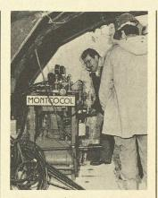
Fig. 3. – L'une des centrales hydrauliques à moteur électrique Enerpac –complète avec distributeurs et manomètres – permettant une mise en charge entièrement sous contrôle. (Photos: Chancy International.)
