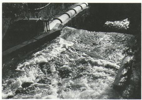
Fig. 10. - Site 2 - Prise d'eau à grille horizontale autonettoyante.
