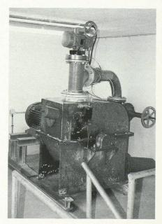
Fig. 4. - Site 1: Turbine Pelton de 50 kW.
