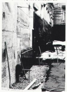
drainage et de filtration Enkadrain, utilisée partout où il s'agit, pour des raisons techniques ou économiques, de bétonner directement sur le terrain (roche, moraine), sans perte de place. Enkadrain CK est composé d'une masse filtrante à structure tri-
