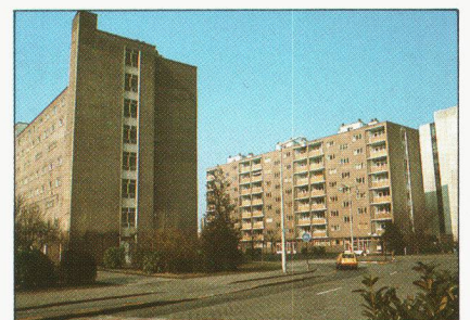
▲ Belgique : Immeuble d'appartements sociaux, Gand. (rénovation)
