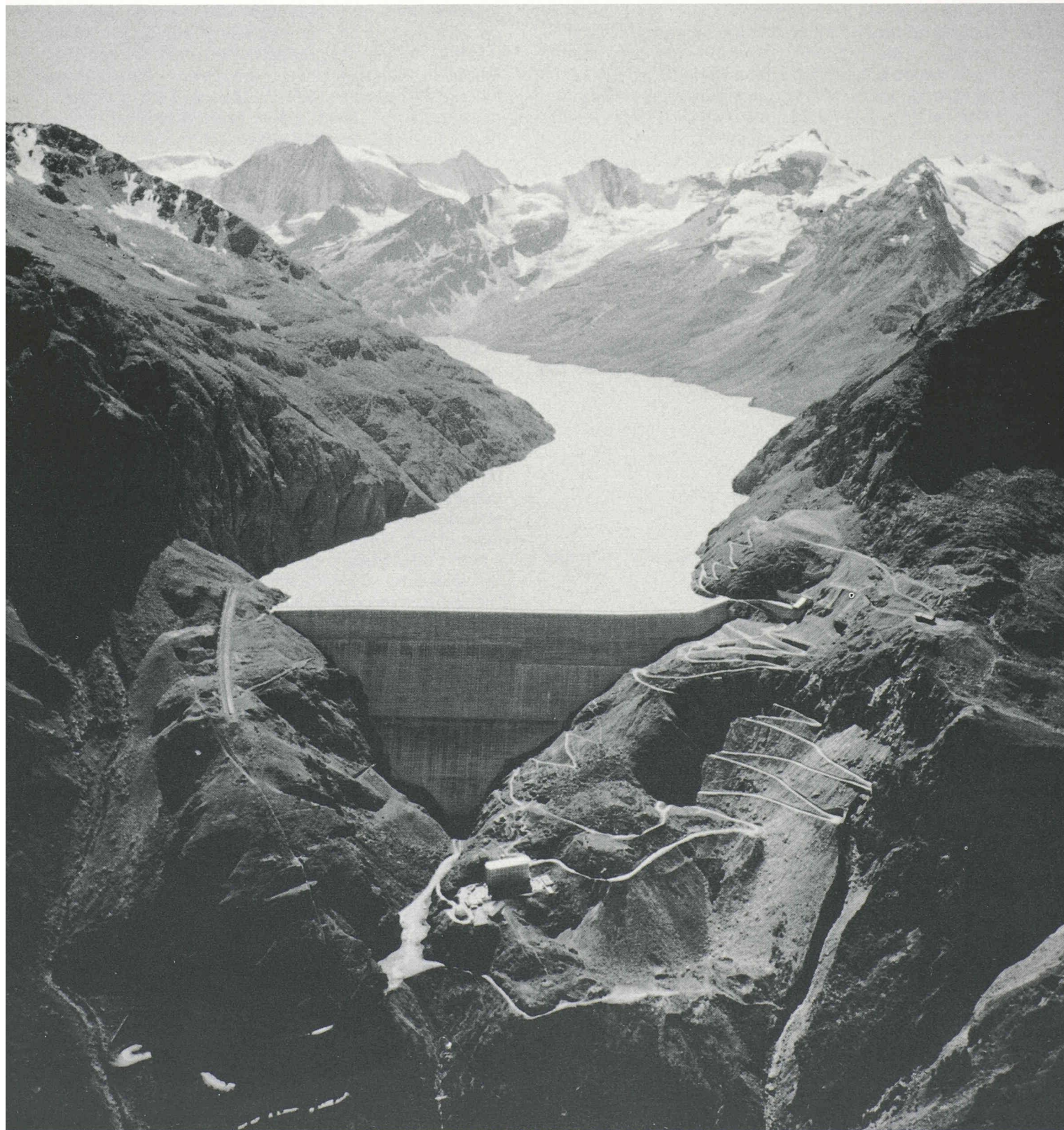
Le barrage de la Grande Dixence (canton du Valais), le plus haut du monde. Hauteur: 285 m. Longueur du couronnement: 695 m. Volume du béton: 5 957 000 m 3 . Construit sous la présidence d'Eric Choisy.
