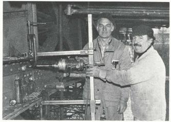
Fig. 11. - Perçage pour remplacement de rivets.
