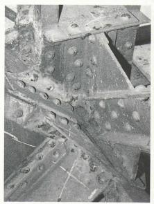
Fig. 13. - Eau stagnante avec forte corrosion.
