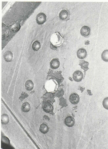
Fig. 12. — Remplacement de rivets par des boulons HR.
