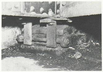
Fig. 16. – Appui à rouleau.
