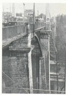
Fig. 6. - Piles salies, garde-fou corrodé.
