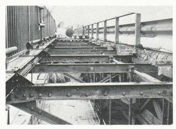
Fig. 10. – Poutre de trottoir avec couche d'époxy-brai.
