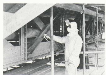
Fig. 8. — Couche de fond de protection contre la corrosion : minimum de plomb avec liant caoutchouc chloré.
