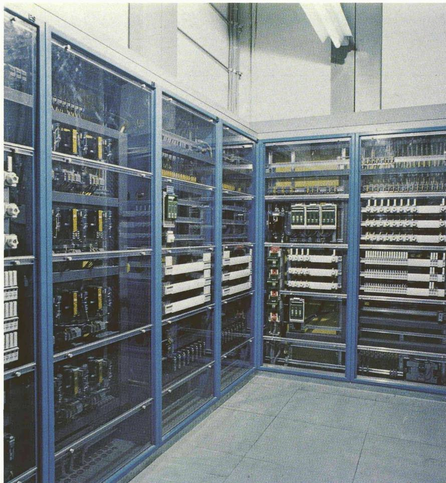
lement sont installés par cabine, pour une puissance totale de 3260 kVA.
