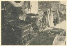
Fig. 5. — Benne de grue, rendue étanche par deux pelletées de sable.
