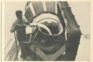
Fig. 1. - Adjonction de mousse sur le chantier.
