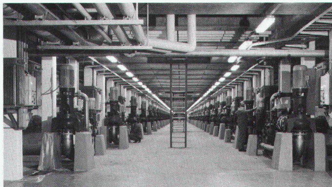
Installation d'épuration Lynetten, Copenhague, 115 pompes TURO.
