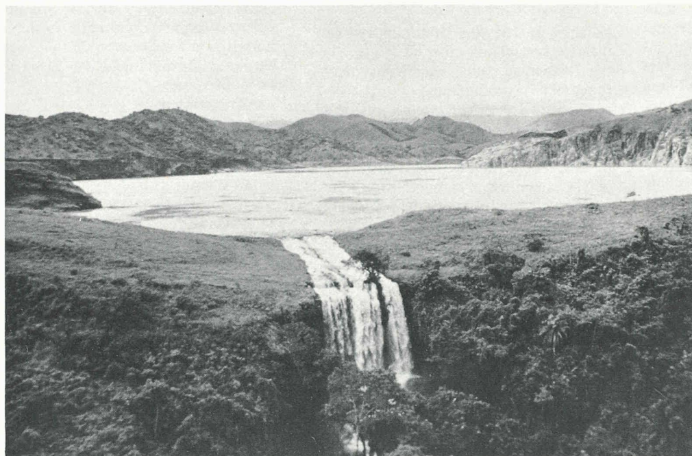
Le lac Nyos après la catastrophe, vu du nord. L'écoulement au nord (premier plan) ne montre pas de signe de marée, bien que le nuage toxique se soit répandu aussi dans cette direction. Sur la berge sud du lac, la ligne blanche (centre de la photo) marque la limite supérieure des dévastations provoquées par la marée orientée vers le sud.
