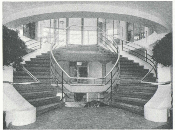
L'escalier central de la rotonde, constitué de marches moulées d'avance et encastrées dans un limon de béton armé.
