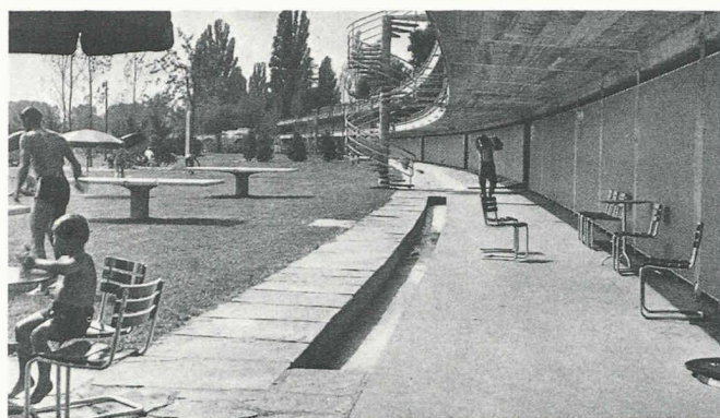
La façade des vestiaires. L'ouverture des cabines vers le couloir intérieur permet de récupérer un porte-à-faux générateur d'ombre et d'échapper à la triste théorie des portes de cabines.
