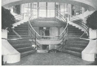
L'escalier central de la rotonde, constitué de marches moulées d'avance et encastrées dans un limon de béton armé.
