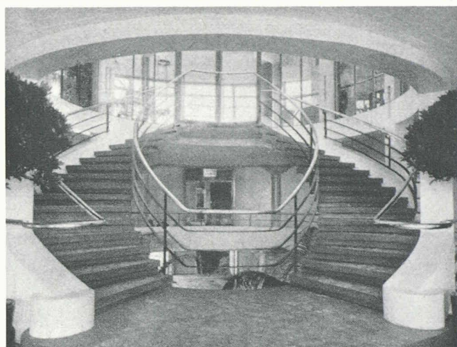
L'escalier central de la rotonde, constitué de marches moulées d'avance et encastrées dans un limon de béton armé.
