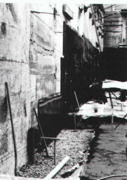
dimensionnelle en fibres de polyamide, sur laquelle est soudée une couche filtrante en polyester, d'un côté, et revêtue d'une couche de PVC étanche au bétonnage servant de coffrage perdu, de l'autre côté.
