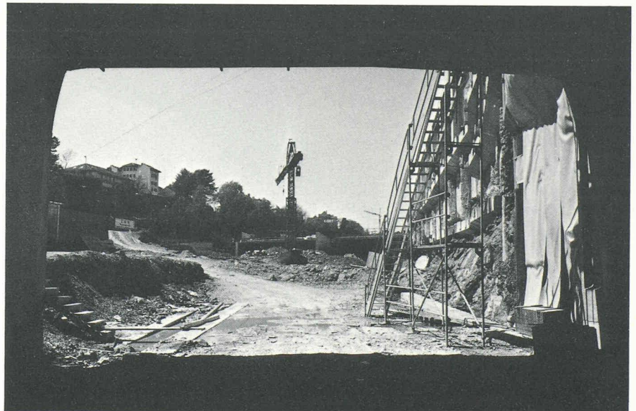
Fig. 7. — Tunnel « Est » : portail du tube nord, vu en direction de l'ouest. L'espace entre les deux portails sera entièrement recouvert.
