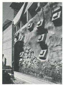
Fig. 6. - Vue partielle de la paroi nord de pieux forés avec les têtes d'ancrage des tirants obli-
