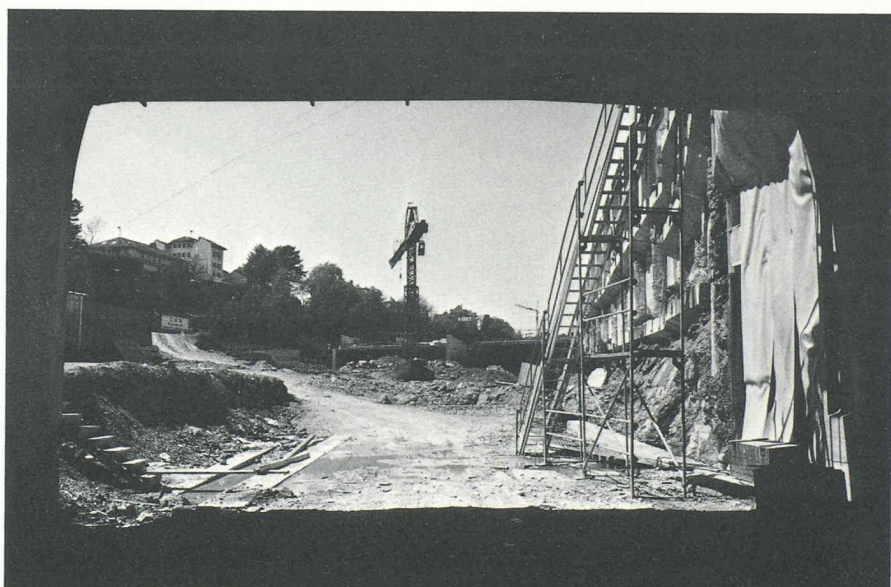
Fig. 7. — Tunnel « Est » : portail du tube nord, vu en direction de l'ouest. L'espace entre les deux portails sera entièrement recouvert.
