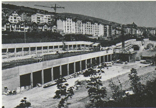
Fig. 12. — Vue d'ensemble de la couverture et des deux portails du tunnel «Est».
