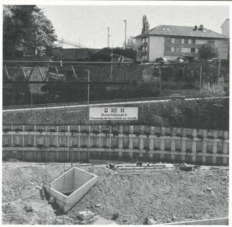
Fig. 4. – Le mur de soutènement sud, composé d'une paroi de pieux forés Ø 40 + 100 cm. Au premier plan : la fenêtre d'aération du Seyon, désormais complètement enterré.
