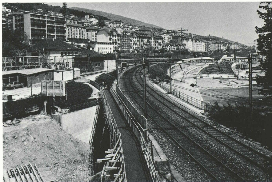
Fig. 10. — Cette vue en direction de l'est montre l'implantation du pont CFF (au premier plan) dans le complexe de l'échangeur de Champ-Coco.
