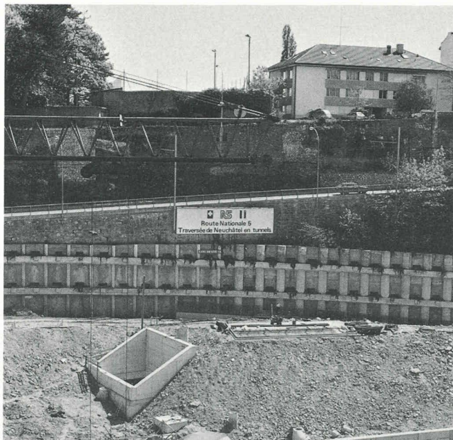
Fig. 4. — Le mur de soutènement sud, composé d'une paroi de pieux forés \varnothing 40 + 100 cm. Au premier plan : la fenêtre d'aération du Seyon, désormais complètement enterré.
