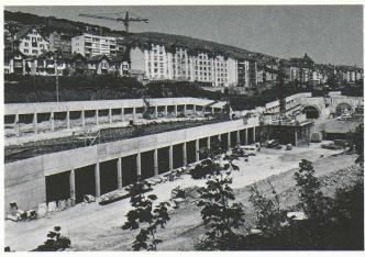
Fig. 12. — Vue d'ensemble de la couverture et des deux portails du tunnel «  $\mathit{Est}$  ».
