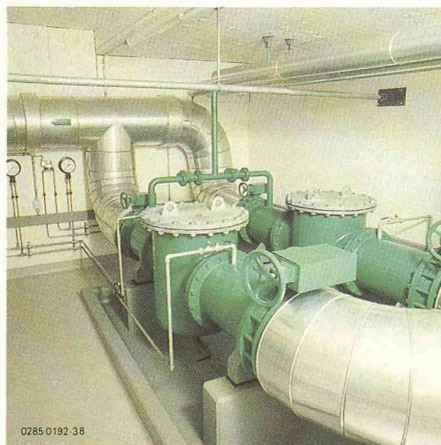
Fig. 3. — Aménée d'eau du lac utilisée comme source de chaleur; station de filtrage.
