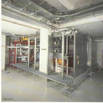
Fig. 6. — Salle des machines comprenant les composants du couplage chaleur-force : alternateurs à moteur à gaz disposés dans la cabine insonorisée dont l'habillage est partiellement démonté; à l'arrière-plan, appareils de récupération des rejets thermiques des gaz d'échappement.
