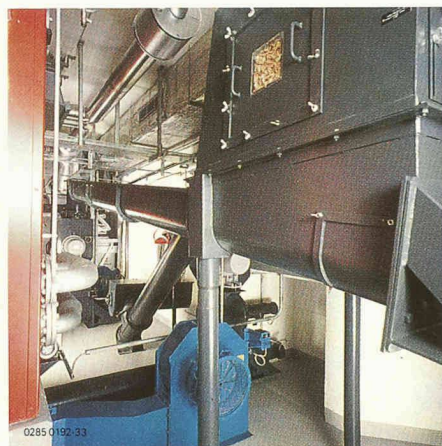
Fig. 7. — Chaudière à copeaux : à droite, système de transport et entreposage intermédiaire ; au premier plan, le ventilateur.
