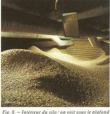
Fig. 8. — Intérieur du silo : on voit sous le plafond les canaux périphériques servant au transport des copeaux.
