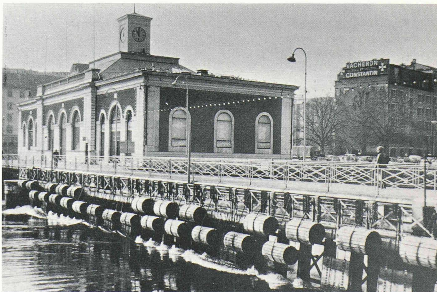
Fig. 2. — Le barrage système Caméré du Pont de la Machine, vue d'amont.
