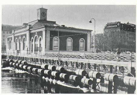
Fig. 2. - Le barrage système Caméré du Pont de la Machine, vue d'amont.
