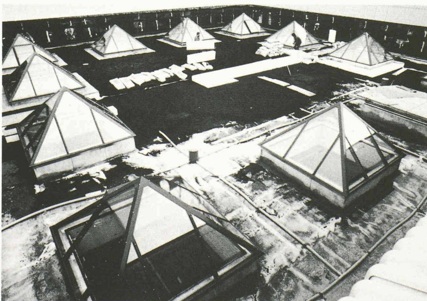
La mise en place des couches drainantes et filtrantes, du réseau drainflex et du terreau sur la toiture compacte.
